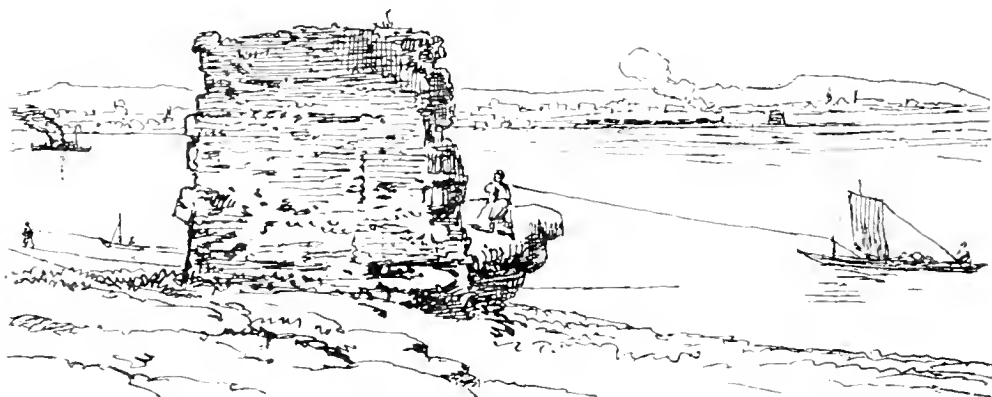
Trajansbrücke, die Köpfeiler im Jahre 1889.
